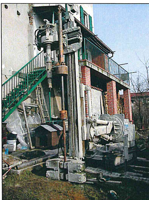
3) Loc. S. Agnese Sondaggio geognostico
